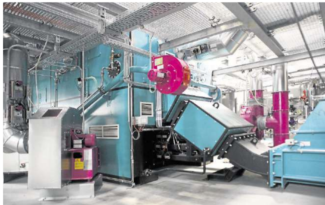
Die neue Heizanlage der Firma Pulverbeschichtung Schreiner
