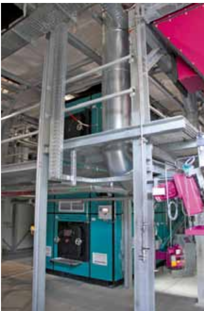
Die im Brennraum (links) entstehenden, circa 850 °C heißen Rauchgase heizen das Wasser im Dampfkessel (rechts) auf über 100 °C auf. Dadurch entsteht 240 °C heißer Dampf mit einem Druck von 32 bar.
