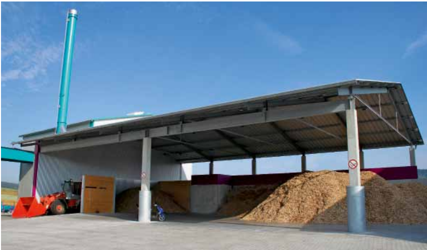
Das Lager ist für 1250 Kubikmeter Hackschnitzel ausgelegt. Das reicht zur Beheizung des Betriebs über etwa sechs Wochen hinweg. Am linken Ende des Baus befindet sich der Heizraum.
