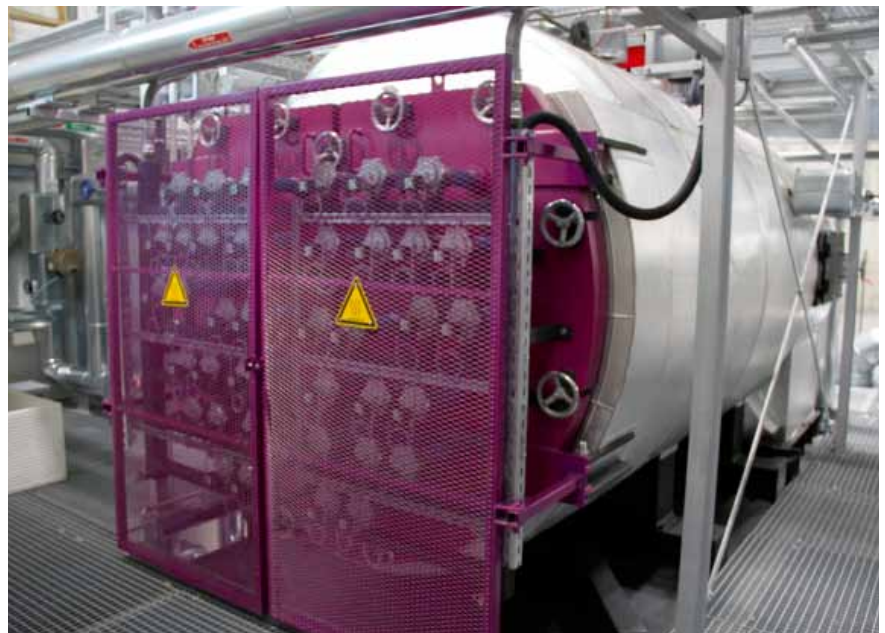
Die im Brennraum (links) entstehenden, circa 850 °C heißen Rauchgase heizen das Wasser im Dampfkessel (rechts) auf über 100 °C auf. Dadurch entsteht 240 °C heißer Dampf mit einem Druck von 32 bar.
